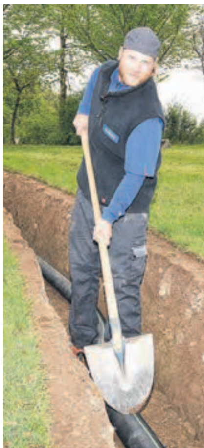
... eine Drainage zu legen ...
